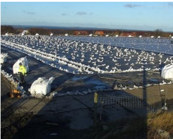
Erdbeckenspeicher, Arcon-Sunmark
